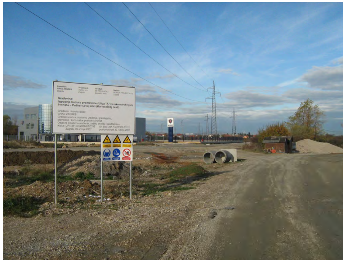
Izgradnja javne prometnice (Ulica „A“)
