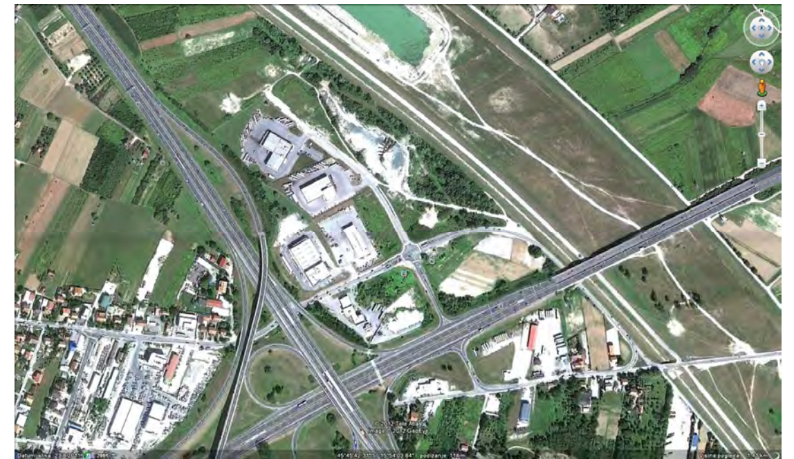
Nakon zamjene stupova 110 kV dalekovoda
