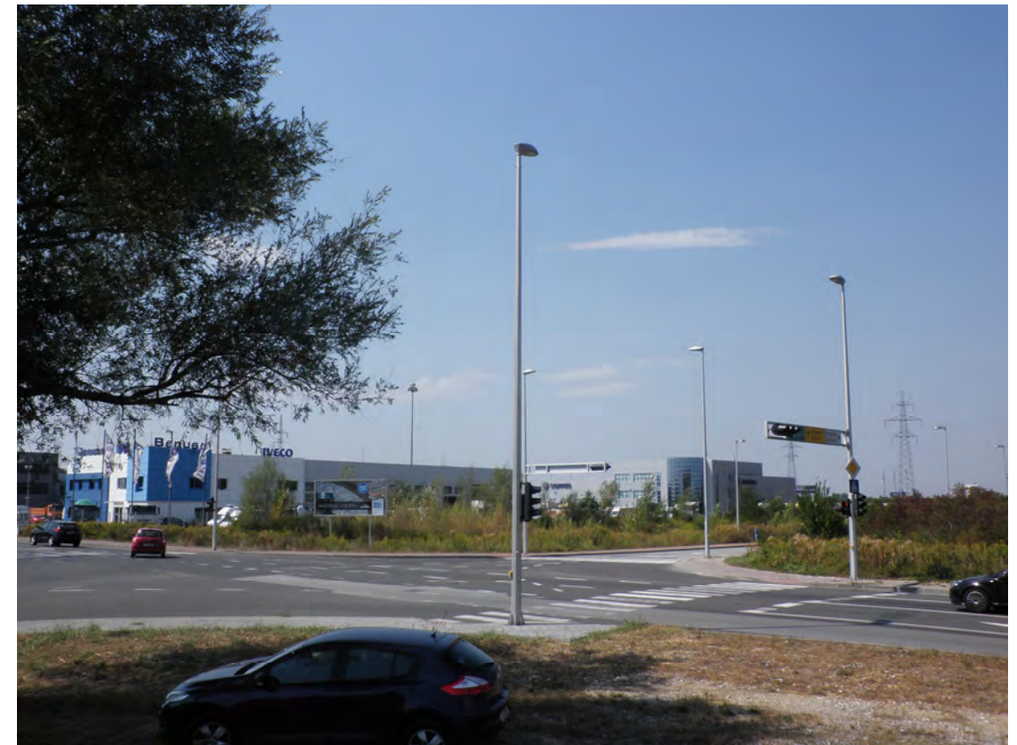
Izgradnja građevina u južnom dijelu (uz Karlovačku cestu)
