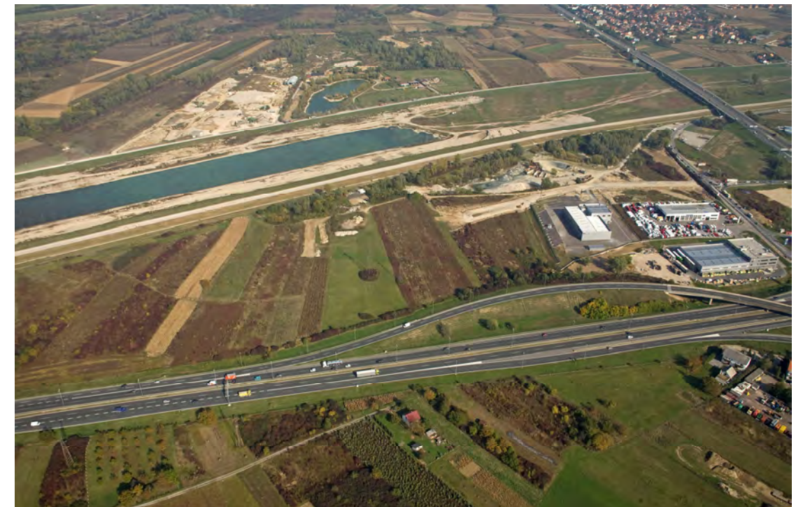
Prije rekonstrukcije 110 kV dalekovoda
